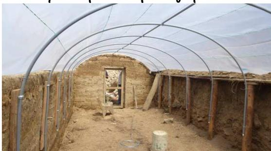
**Paso 2:** Nosotros ayudamos en la compra e instalación de vigas sólidas para soportar el techo.
