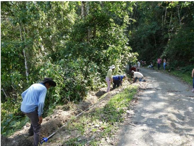
Die Wasserrohre wurden unterirdisch vergraben, um sie vor Beschädigungen zu schützen.
